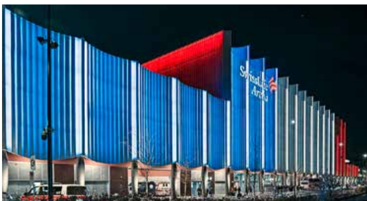
Ein Prunkbau auch von aussen: Die Arena bei Nacht.
