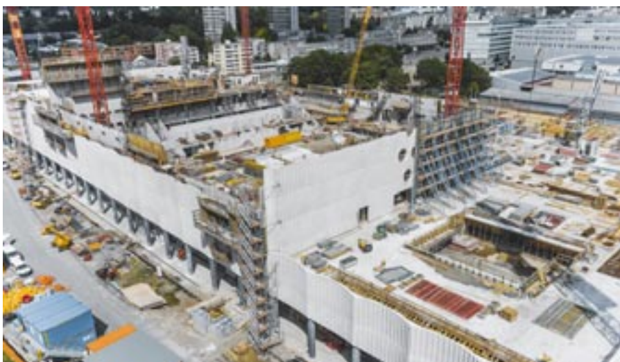
Baufortschritt Stand Ende Juni. Die gut erkennbare Publikumsterrasse auf der rechten Seite ist erstellt, es fehlt noch die 17m breite Treppe als Zugang
