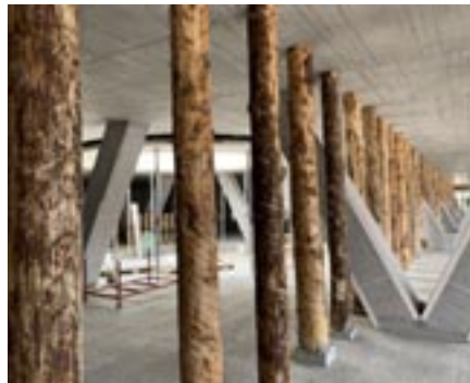
Notspriessung mit Baumstämmen im Businessclub 3. OG: Sobald die Tragstruktur tragfähig ist, werden diese entfernt
