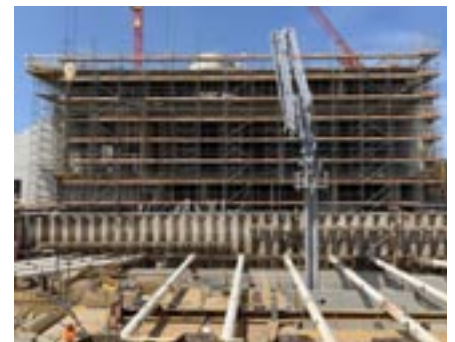
Gut ersichtlicher Unterschied im Baufortschritt der einzelnen Gebäudeteile im nordöstlichen Bereich der Baustelle
