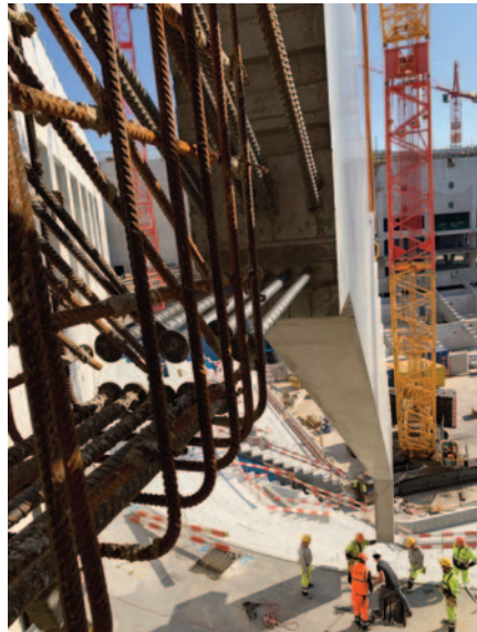
Montage eines Tribünenträgers oberer Rang
