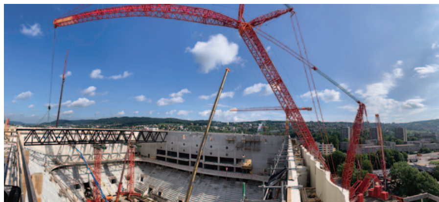
Einheben der ersten beiden Zwillingsträger mit dem grössten Kran der Schweiz
