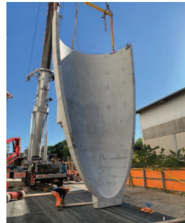
Anheben eines Lichtkelchs
